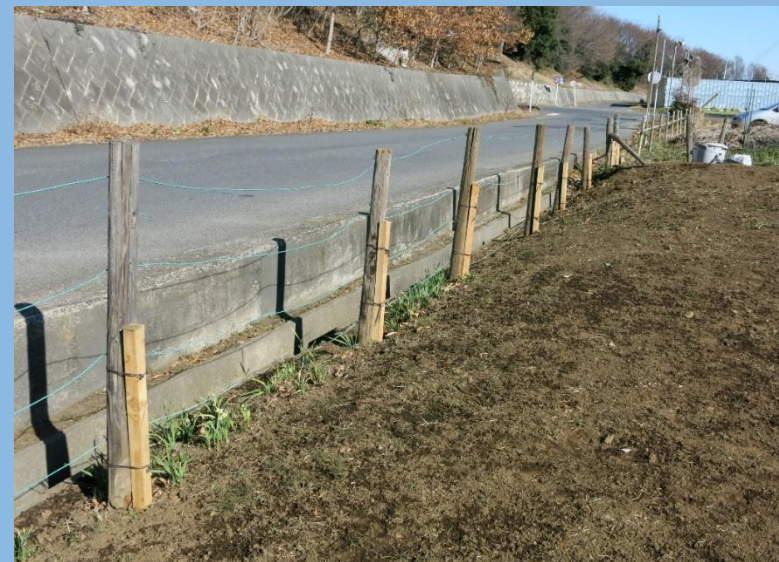
修復完了状況
