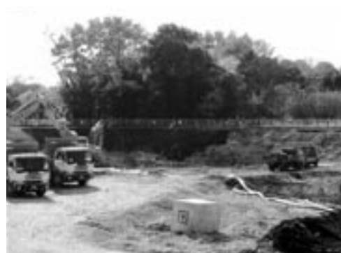
入曾調節池の掘り下げ工事
