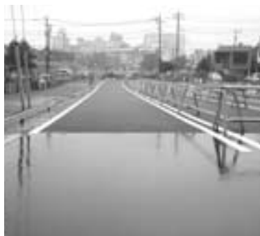
狭山市駅東口に向かう道路整備
