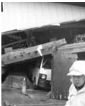
中越地震、川口町内の被災現場
