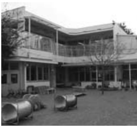
改修が急がれる祇園保育所
