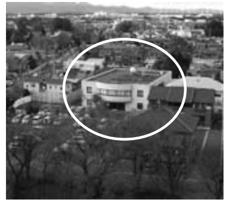
解体予定の市役所北側の法務局
