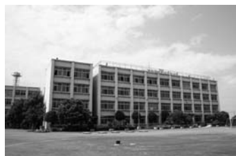
耐震補強工事予定の校舎(南小)
