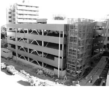
建設が進む狭山市駅西口駐車場
