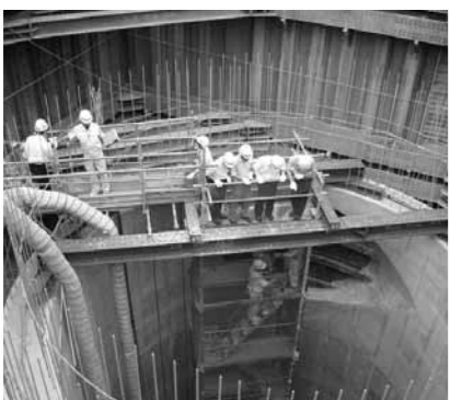
特殊人坑(マンホール)を視察。 内径は7.5m
