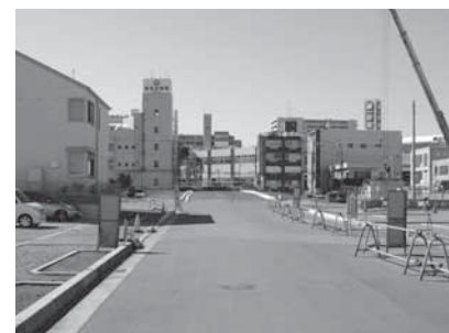
工事中の狭山市駅東口
