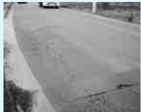
年数が経過しひび割れた道路
