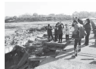
上奥富堰の被災状況を視察
