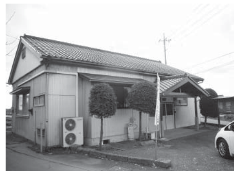
老朽化が進む自治会館
