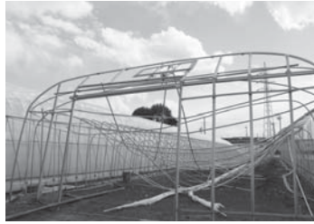
市内での被害の様子
