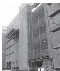
建築中の市営住宅鶴ノ木団地
