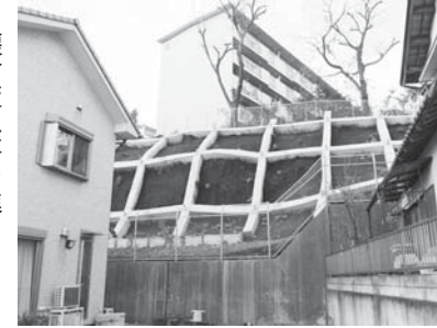
崩壊対策工事を進める 上ノ原市営住宅の地域
