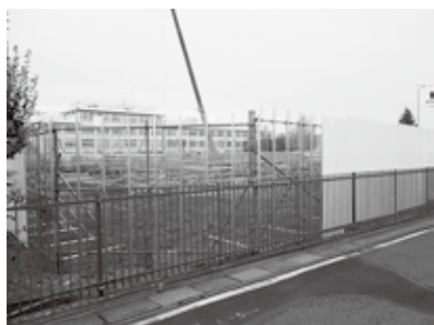
建設中の入曾地区 地域交流施設(仮称)
