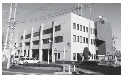
埼玉西部消防局庁舎
