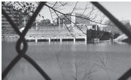
水位があがった 狭山台図書館の調整池
