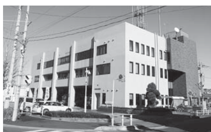
埼玉西部消防局庁舎
