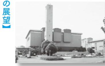
稲荷山環境センター
