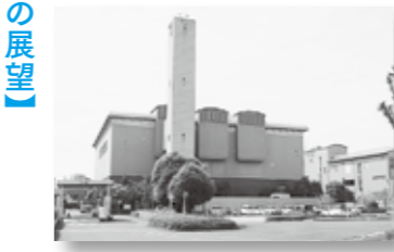
稲荷山環境センター
