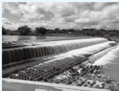
大規模水害に備え強靱化を(奥富堰)
