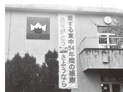
解体前の東中学校 正門入り口
