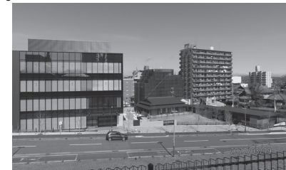
中央公民館跡地建設
