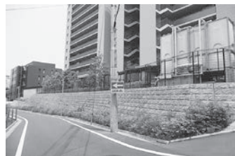
新設された擁壁
