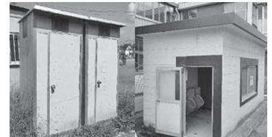
富士見・入間川東小の屋外トイレ
