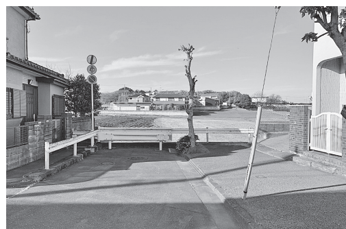
整備が中断している 入間川入曽線
