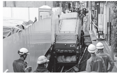
老朽化した埋設物が原因の事故例
