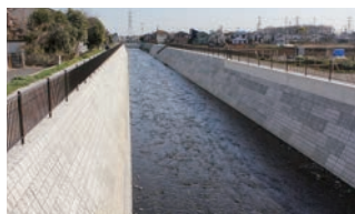
河川改修により整備された護岸のようす
