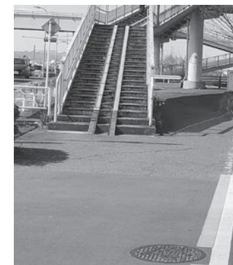
歩道橋脇の幅員の狭い歩道
