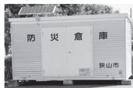
市役所敷地内の防災備蓄倉庫
