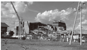
着々と工事が進む入曽駅舎
