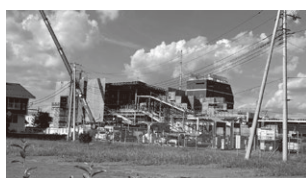
着々と工事が進む入曽駅舎
