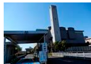
稲荷山環境センター
