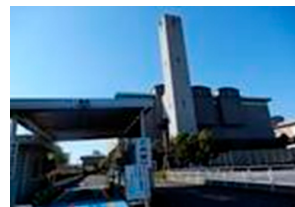
稲荷山環境センター
