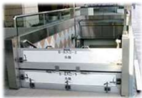
写真 防水板設置の例
