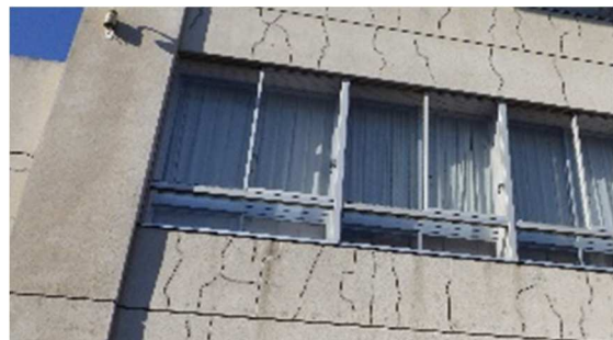
外壁にひび割れ補修跡が多数見られる。ひび割れから雨水等がコンクリート躯体に浸入し、劣化を進行させる。ひび割れ補修と再塗装により、コンクリート躯体を長持ちさせることが長寿命化には重要。
