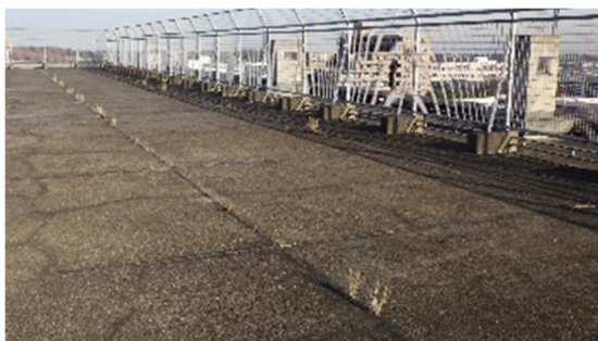
※保護防水に表面摩耗が見られる。目地の劣化により、雑草や苔が生えている。下階に雨漏りしている場合もある。 ※保護防水は、耐用年数の長い工法。
