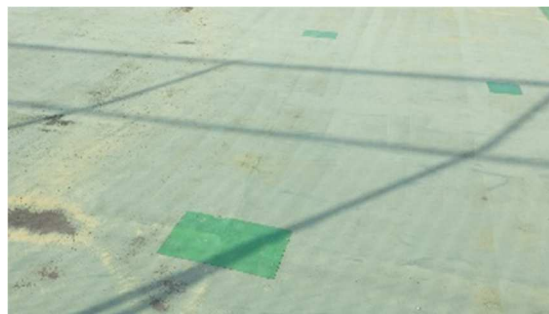
※露出防水（塗膜）に補修跡が多数見られる。経年により、改修時期を迎えている。 ※露出防水は、適正時期に改修が必要。
