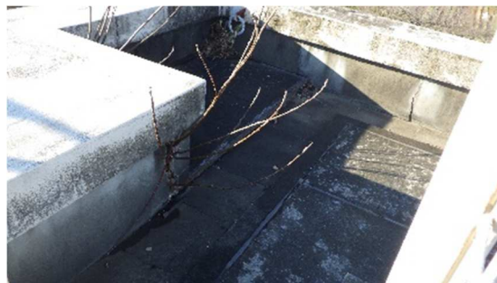
防水層に植物が生えている。植物の根は防水層を破り雨漏りにつながる。枯れ葉などがルーフトレの詰まりにつながるため、定期的な清掃も重要。
