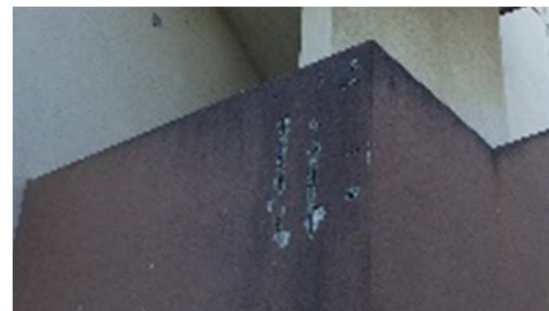
雨水の浸入により、鉄筋の腐食膨張が起きて、コンクリートが剥落している。躯体補修と再塗装が必要。適正時期に再塗装することで、コンクリート躯体を保護することが重要。
