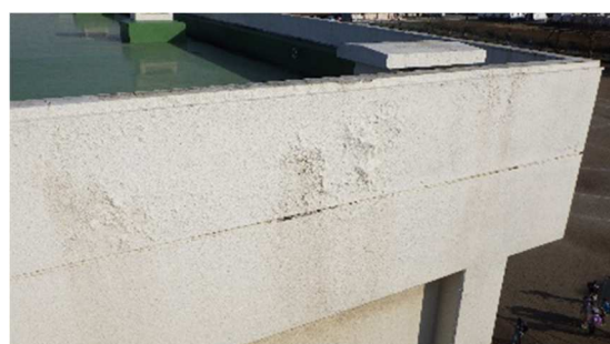
吹付材とコンクリートの間に雨水や空気が入り、膨れや剥離等の劣化が進行。コンクリート躯体にひび割れ等があると劣化を進行させる。適正時期に再塗装する必要がある。
