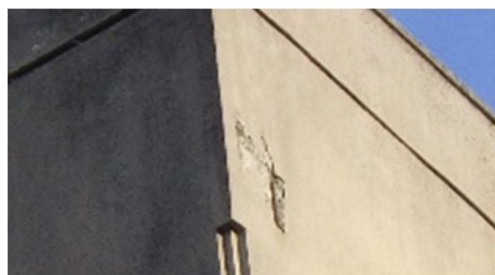
外壁のモルタル部分が剥落している。児童・生徒がケガをする恐れもあるため、日頃から点検することが望ましい。落下しそうな部分は先に落とし、児童・生徒が近づかないような対処が必要。
