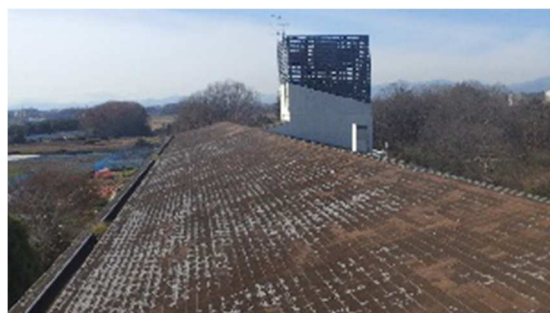
シングル葺きの勾配屋根に汚れ、苔が生えている。再塗装することで、長く使用することができ、美観も損なわない。金属屋根も同様に腐食させないことが重要。
