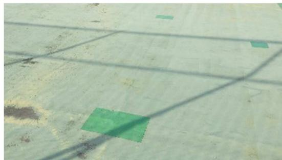
※露出防水（塗膜）に補修跡が多数見られる。経年により、改修時期を迎えている。
