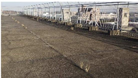
※保護防水に表面摩耗が見られる。目地の劣化により、雑草や苔が生えている。下階に雨漏りしている場合もある。
