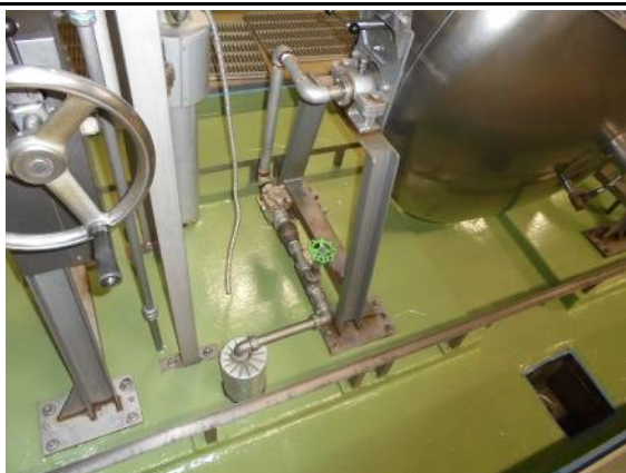
IM-43 回転釜用蒸気戻り管
