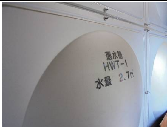
IM-10 蒸気用還水槽固定状況
