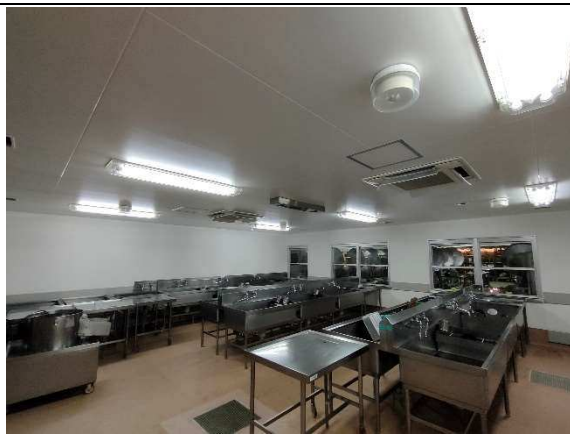
i-34) 照明器具等取付状況
