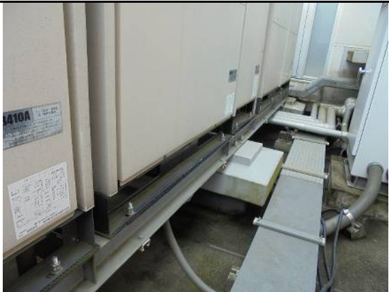
IM-71 マルチエアコン室外機据付状況
