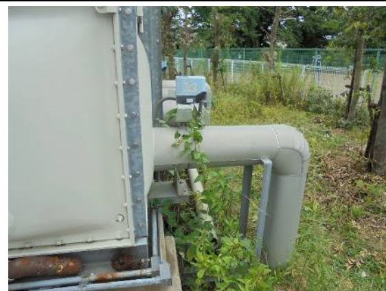
IM-7 給水緊急遮断弁
