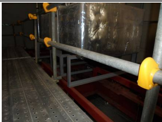
IM-67 天井内機器メンテ用通路
