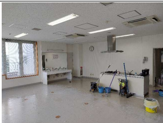
i-96) 会議室機器状況
