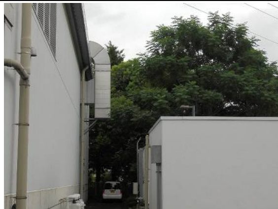
KM-8 外壁面露出排気ダクト
