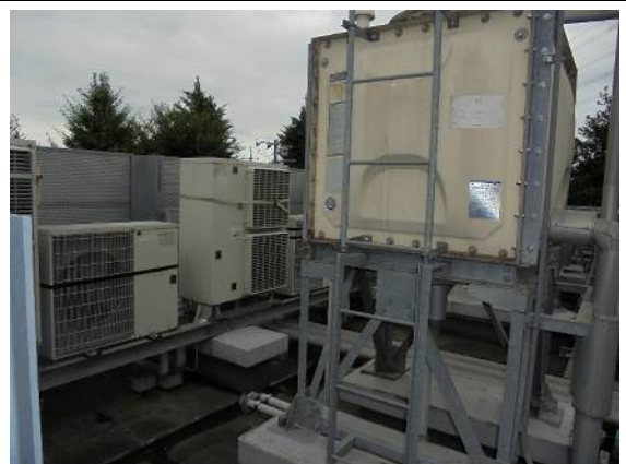
KM-66 消火用補助水槽+鉄骨架台
