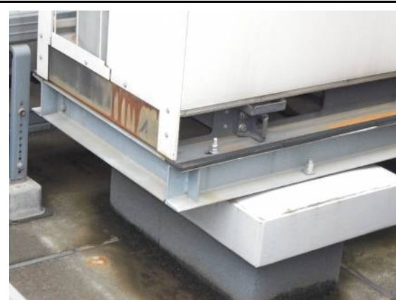
KM-64 マルチエアコン室外機、据付状況
