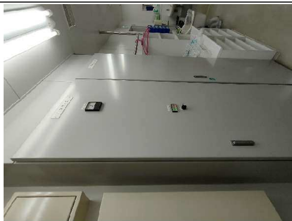
i-52) 分電盤、動力盤 1ML-2 1MP-2
