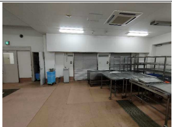
i-48) 照明器具等取付状況
