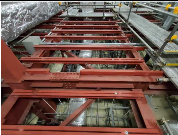
i-17) 機械室内配線状況
