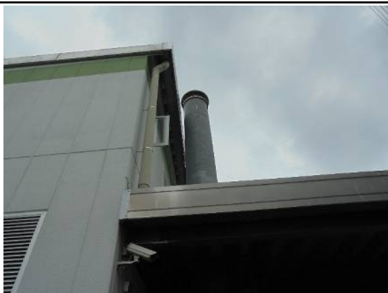
KM-17 ボイラ煙突上部
