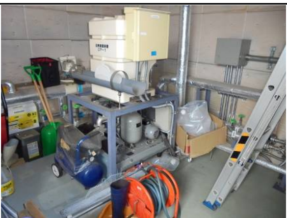
KM-13 散水用給水加圧ポンプユニット
