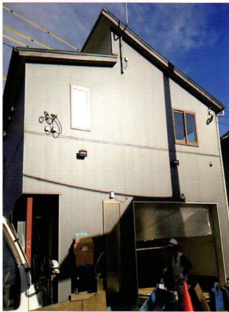
建設中の第6分団第1部車庫
