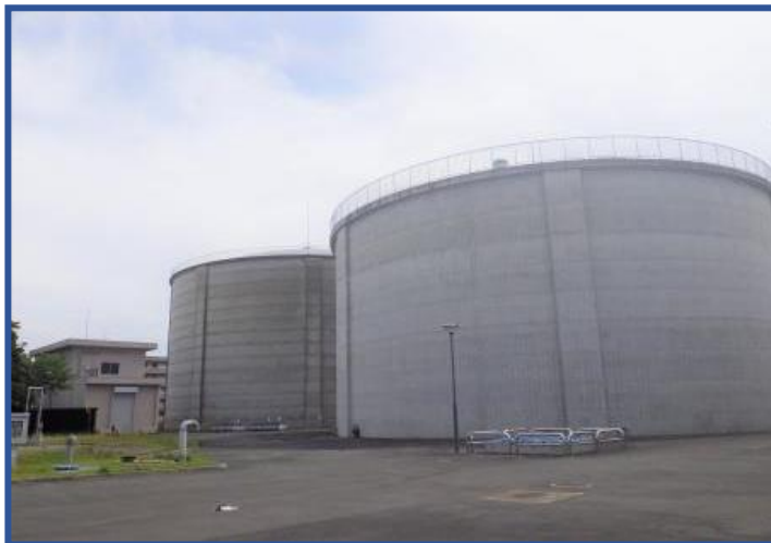
【稲荷山配水場】
