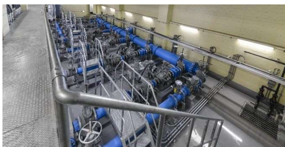
稲荷山配水場の配水ポンプとインバータ盤
