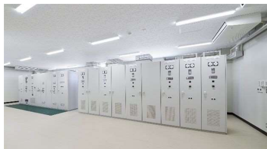
稲荷山配水場の配水ポンプとインバータ盤
