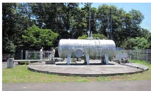
水野浄水場 貯水槽
