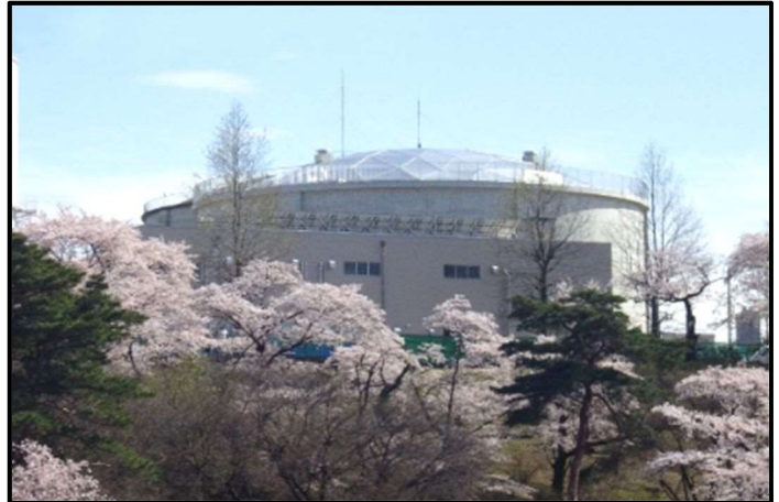
【稲荷山配水場】
