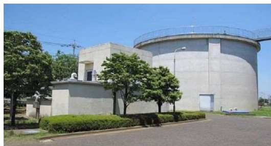
堀兼浄水場 着水井・揚水ポンプ井・配水池
