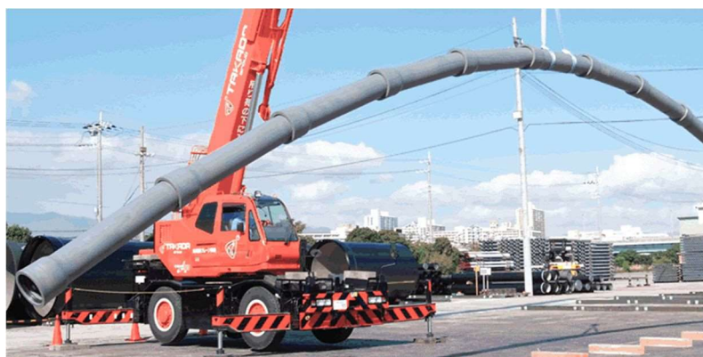
耐震型ダクティル鑄鉄管
