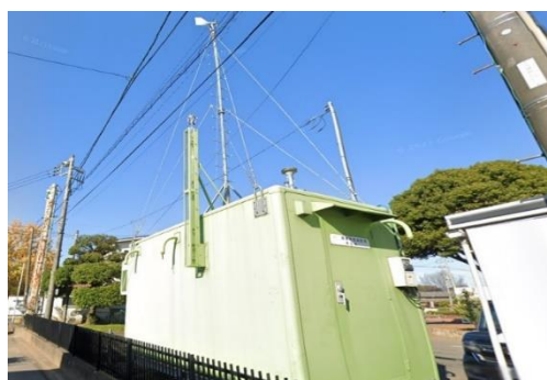
一般大気常時監視測定局 (堀兼公民館)
