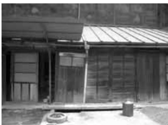
05. 水車場搗き場入口、幅 2 m 水路の暗渠が屋内へ延びている
