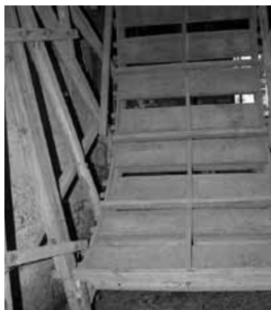
59. 昭和 38 年頃以来使われなくなった水輪下部は湿気のため腐朽欠損している
