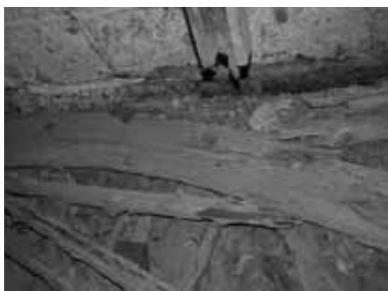
65. 腐朽破損した海老樋の残骸
