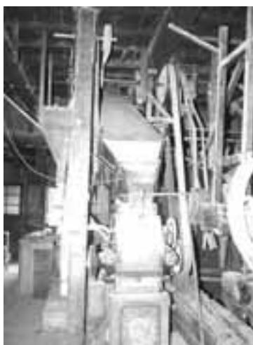
53. 電動機で稼動する現在の製粉機
