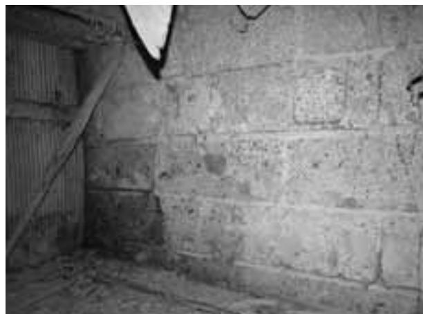
67. 大正 4 年 9 月手製のコンクリートブロックを積み上げて用水路を三面張に改修した。当初の用水路は玉石を粘土で固めて積む石垣だったらしい
