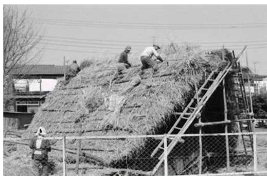
昭和 55 年（1980 年）屋根葺き替え中の復元住居
