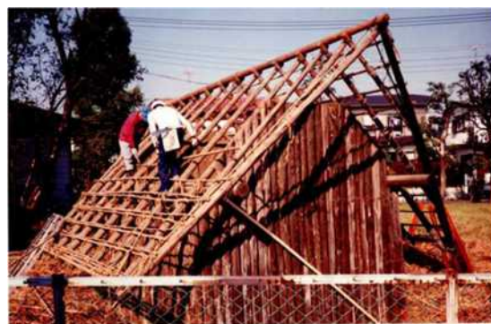
平成 5 年（1993 年）解体中の復元住居
