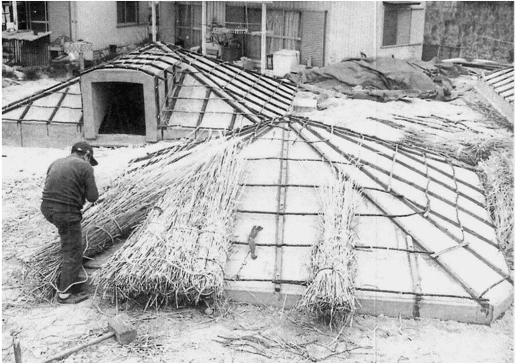
图 38 2 案整備事例 中筋遺跡 3 号竖穴式住居（群馬県渋川市）
