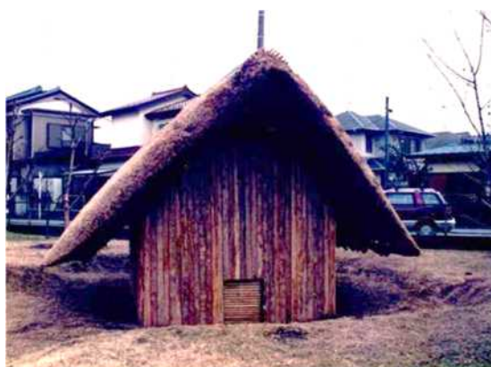
平成 5 年（1993 年）屋根及び壁の全面改修
