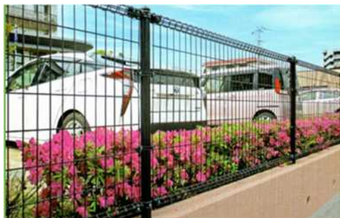
図 47 メッシュフェンスの整備
