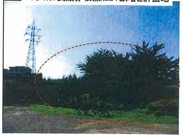
154kV武蔵赤坂線No.21鉄塔と計画地
