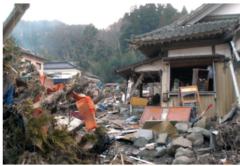
津波で崩れ、流された家屋
