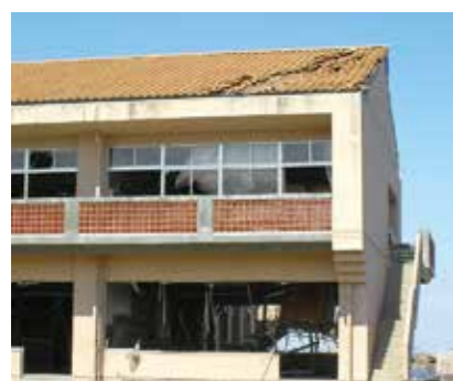
屋根瓦の一部が損壊した校舎
