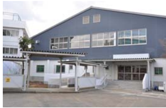
23年度に耐震補強工事が実施された奥富小学校の体育館。24年度は4校を実施
