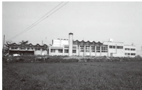
最新の厨房機器を備え、1日1万食の調理が可能に(昭和47年)
