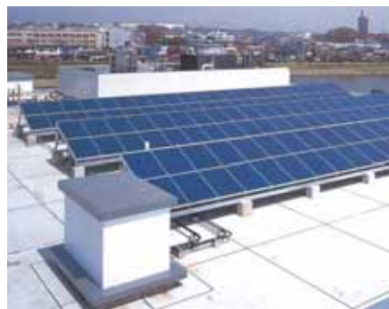
今後3年間で、30施設に太陽光パネルなどを整備(写真は入間川小学校)
