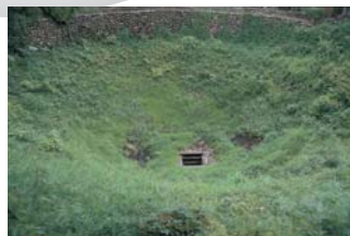
工事前の七曲井
